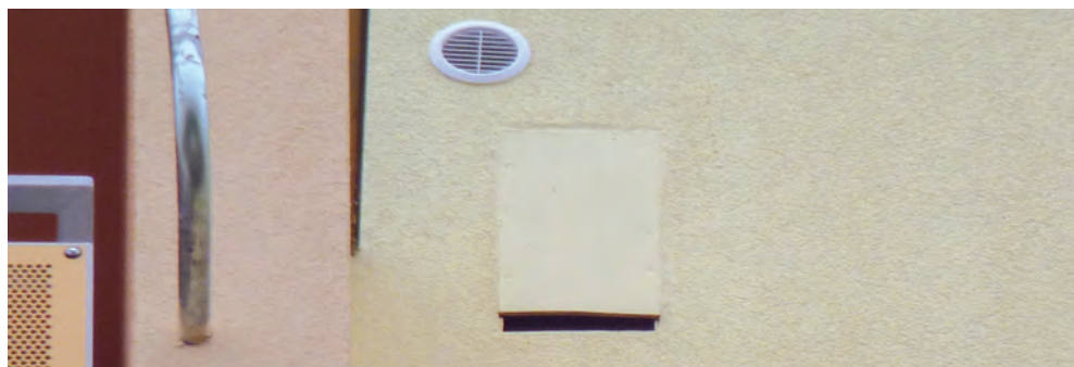
Fot. 111. Nie zawsze trzeba posilkować się rozwiązaniami gotowymi. Ten schron dla nietoperzy powstał poprzez zamontowanie płyty z tworzywa sztucznego przykrywającej trzycentymetrową przestrzeń wyciętą w styropianie (DZ)
