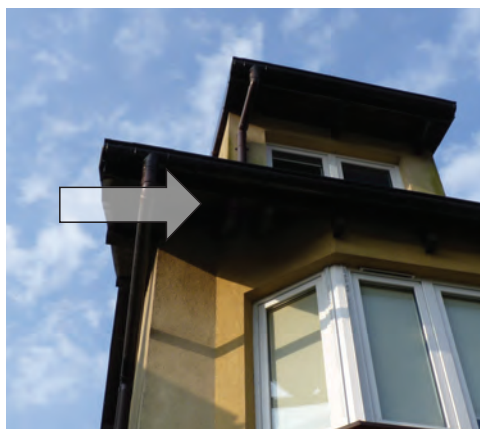
Fot. 53. Domy jedno- i wielorodzinne też posiadają liczne miejsca, które nadają się do zajęcia przez ptaki lub nietoperze. Tutaj w szczelinie tuż obok krokwi gniazdowały wróble, podobny ubytek może prowadzić do miejsca zajmowanego przez nietoperze (DZ)
