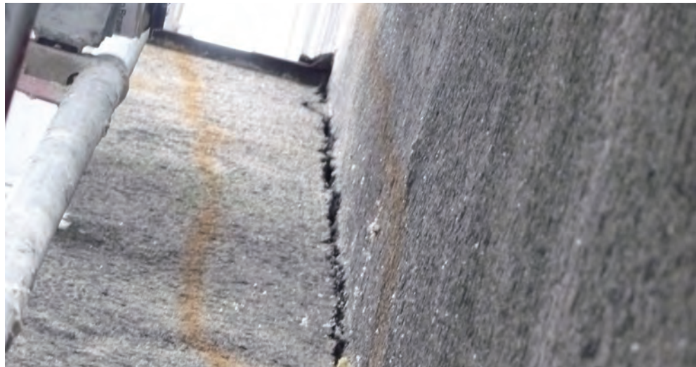
Fot. 83. Ta szczelina dylatacyjna o szerokości od 1,5 do 2,5 cm prowadziła do zimowiska borowców wielkich (DZ)
