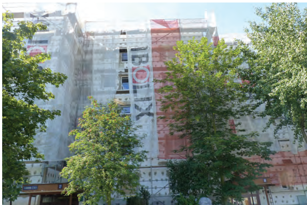
Fot. 21. Budynek wielkopłytkowy w trakcie docieplenia (DZ)
