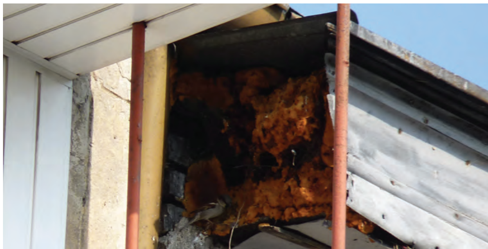
Fot. 51. Uszkodzona boczna część gzymsu umożliwiła gniazdowanie w jego wnętrzu wróblom oraz jerzykom (DZ)
