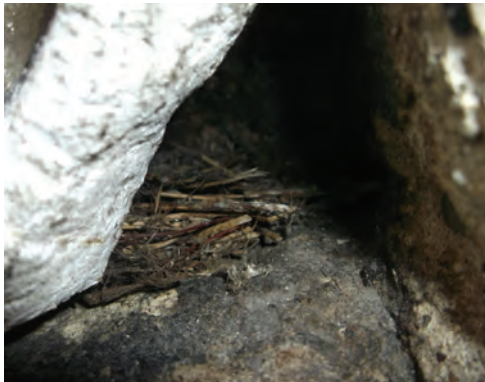
Fot. 63. Za tym elementem sztukaterii gniazdo wybudowała para wróbli, a niewielka szczelina w rogu prowadziła do wnętrza większego ubytku (DZ)
