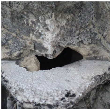
Fot. 62. Wykonana z gipsu sztukateria w kamienicach często ulega uszkodzeniu, odsłaniając puste wnętrze, które staje się dogodnym miejscem do wybudowania gniazda (DZ)
