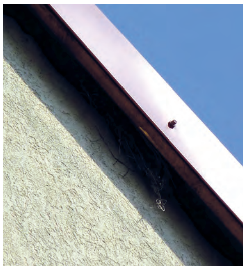
Fot. 61. Wróble potrafią nanieść sporą ilość materiału do wybudowania gniazda. Jego nadmiar wystaje potem na zewnątrz elewacji (DZ)
