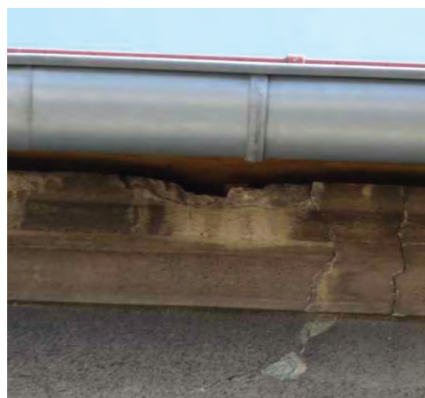
Fot. 100. W tej szczelinie pod krawężnią dachu Urzędu Miasta w Szczecinie gniazdowała para jerzyków. Po remoncie elewacji pozostawiono im swobodny dostęp do gniazda poprzez otwór o wysokości 3,5 cm i szerokości 6 cm (DZ)
