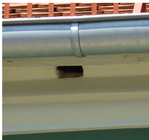
Fot. 100. W tej szczelinie pod krawężnią dachu Urzędu Miasta w Szczecinie gniazdowała para jerzyków. Po remoncie elewacji pozostawiono im swobodny dostęp do gniazda poprzez otwór o wysokości 3,5 cm i szerokości 6 cm (DZ)
