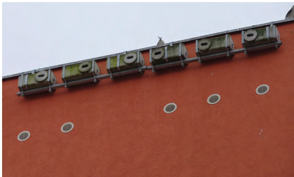
Fot. 108. Skrzynki dla jerzyków wykonane z trocinobetonu i zawieszone na stelażu (DZ)
