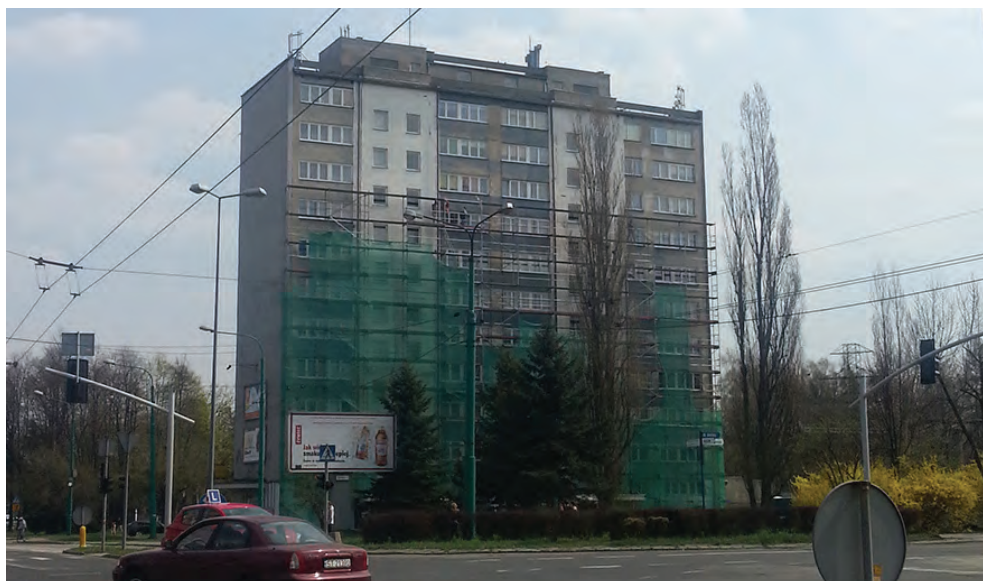
Fot. 135. Remontowany blok (DC)
