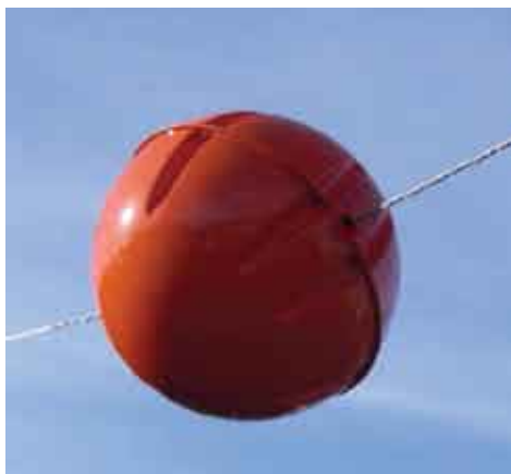
Fot. 1. Kula minimalizująca ryzyko kolizji zapewniająca bezpieczeństwo żeglugi powietrznej (APLIC 2012).
